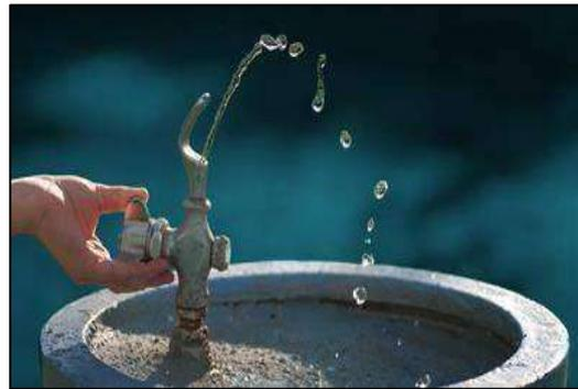
Los bebederos se encuentran en mal estado, cuando el aparato surtidor se encuentra deteriorado o inoperativo; o su pedestal se encuentra roto con partes cortantes expuestas; o el sistema de purificación de agua se encuentra inoperativo; o sus cañerías se encuentran obstruidas, impidiendo el normal consumo de agua cuando ésta se encuentra disponible en el local educativo.
