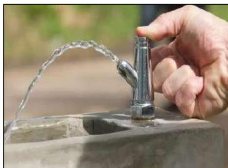
Los bebederos se encuentran en buen estado, cuando el aparato surtidor se encuentra operativo sin presentar fugas o goteo y la altura donde está instalado es acorde con la edad de los estudiantes del nivel educativo en uso, los canales de purificación del agua operan regularmente y, cuenta con abastecimiento de agua cuando ésta se encuentra disponible en el local educativo.
