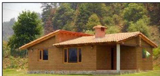
**Albañilería sin confinar:** Es una estructura donde no existe amarre entre el muro, la Numeral y viga; sino que solamente están unidas con mortero en las Numerals y las vigas simplemente están apoyadas en los muros.
