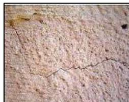
**Fisuras moderadas o ataques de sales:** Fisuras más anchas y/o más extendidas. Presencia de eflorescencias (manchas blancas), descamación o desintegración superficial debido a la cristalización de sales.
