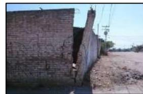
**Muro de contención:** Es una estructura rígida que previene el desborde del material que contiene (agua o tierra).
