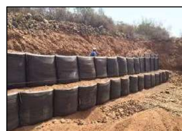
Muros de gravedad gaviones flexibles
