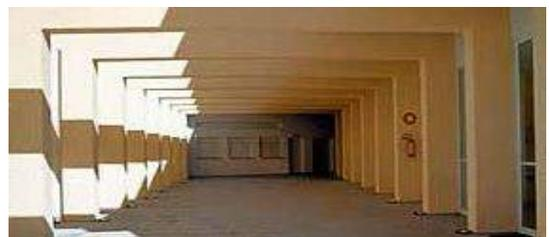
**Dual:** Es conocido por la utilización de dos sistemas estructurales con funcionamiento estructural acoplado, para un solo bloque de edificación (Estructura Aporticada + Muros de Abañilería confinada).
