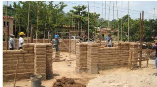
**Albañilería sin confinar:** Es una estructura donde no existe amarre entre el muro, la columna y viga; sino que solamente están unidas con mortero en las columnas y las vigas simplemente están apoyadas en los muros.
