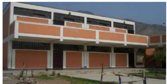
**Albañilería confinada:** Es la técnica de construcción que se emplea en una edificación, donde se utilizan elementos de confinamiento (columnas de amarre y vigas soleras), y muros de ladrillos de arcilla cocida, que hacen que tenga un comportamiento como un todo.
