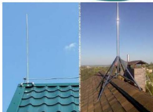
**Pozo a tierra:** También denominado hilo de tierra, toma de conexión a tierra, puesta a tierra, polo a tierra, es un sistema de protección que se emplea para proteger las instalaciones eléctricas y las antenas o pararrayos contra las descargas eléctricas como por ejemplo el rayo, evitando el paso de corriente a los usuarios. Generalmente se encuentran ubicados en el patio, cerca al ambiente TIC, en el jardín, es un orificio que puede ser cuadrado o redondo con tapa.
