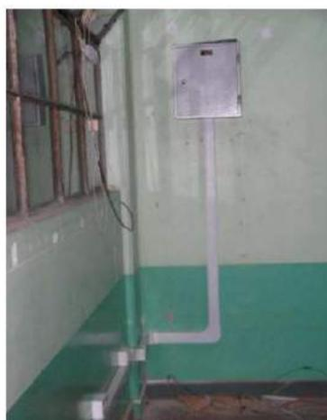
El tablero eléctrico es la parte principal de la instalación eléctrica, en el mismo se encuentran todos los dispositivos de seguridad y maniobra de los circuitos eléctricos de la instalación. Consiste en una caja donde se montan los interruptores automáticos respectivos, cortacircuitos y fusibles, y el medidor de consumo
